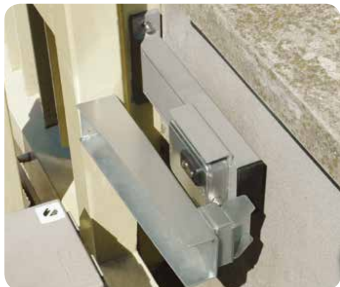
Applicazione su "montante antiribaltamento" utilizzando la "piastra a T" di fissaggio del kit.
